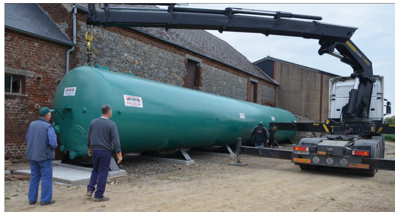
Mise en place de la cuve: 19m de long, diamètre de 2.6m, poids de 13 tonnes
