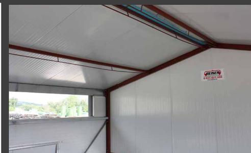
Longs-pan et façades en panneau sandwich 40 mm sur hauteur 1 m
