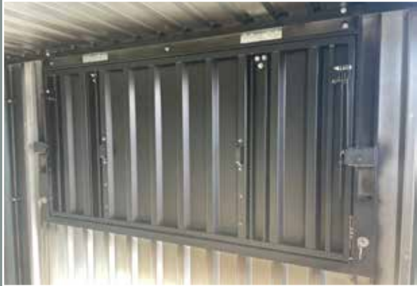
Vue intérieure de la fenêtre avec verrouillage sur les 2 côtés
