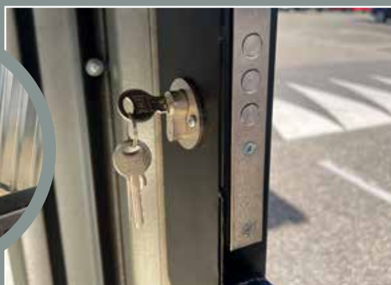
Système de verrouillage de la fenêtre, clé (3 jeux similaires), serrure et cylindres
