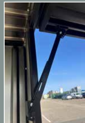
Mécanisme de la fenêtre en position ouverte
