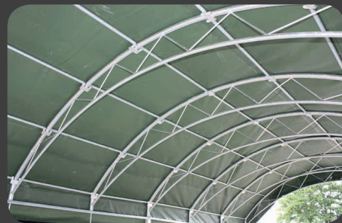
Arceaux de toiture renforcés
