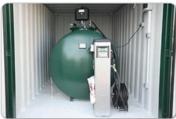
Installation avec un distributeur à gestion intégré 90L/Min et enrouleur
