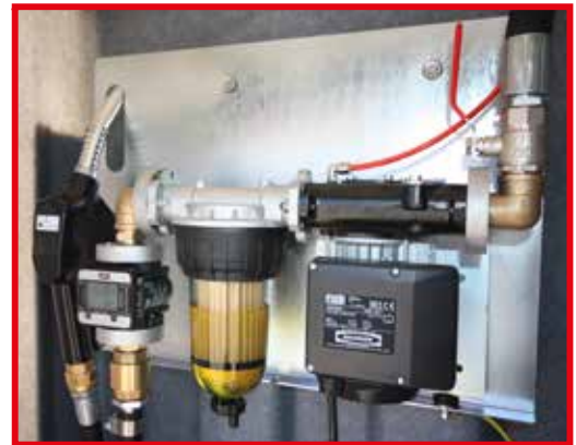
Pistolet automatique, pompe 79L/min 220V, avec compteur digital, filtre décanteur d'eau et vanne pour couper l'alimentation vers la pompe.
