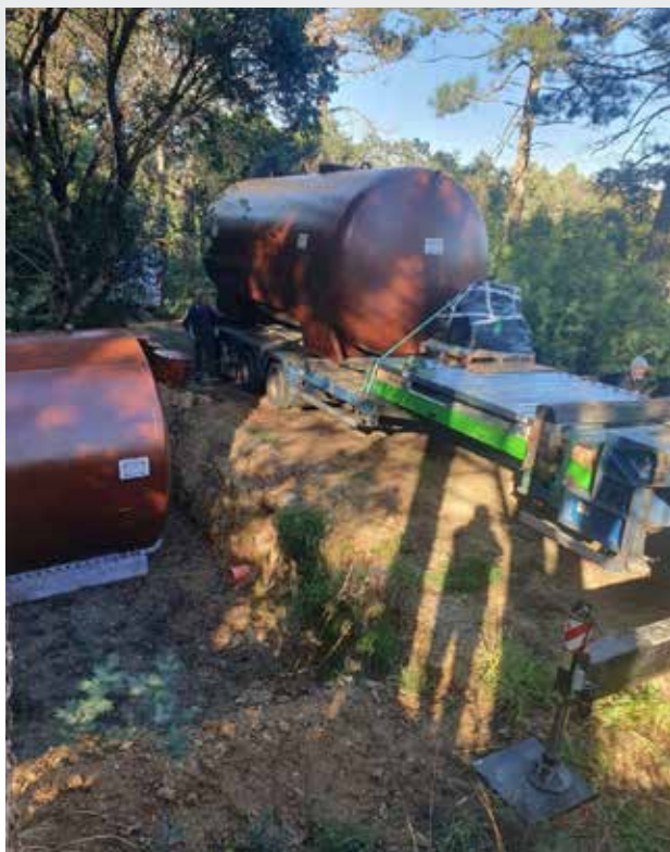
INSTALLATION DE DEUX STATIONS À ENTERRER DANS LE TROU PRÉVU
