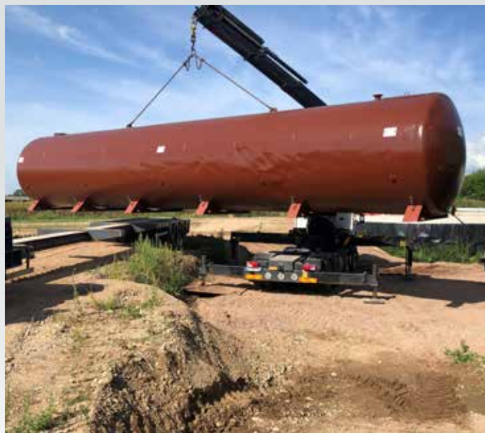
ARRIVÉE SUR SITE ET MISE EN PLACE D'UNE CITERNE 120 000 PAR CAMION GRUE
