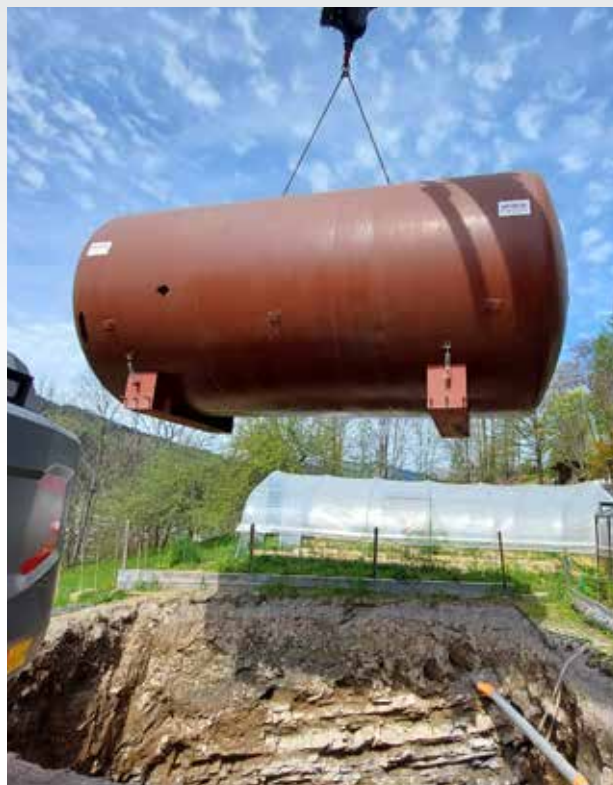
DÉPOSE DE LA STATION DANS LE TROU PAR GRUE
