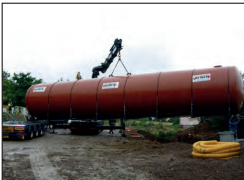
> Déchargement par camion-grue
