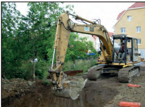
> Excavation pour la mise en terre
