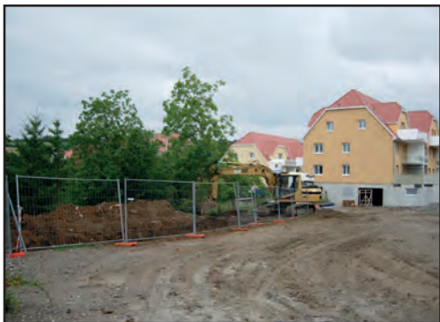
> Préparation du site
