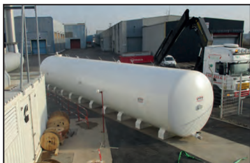
> Citerne installée par notre camion-grue sur un site industriel
